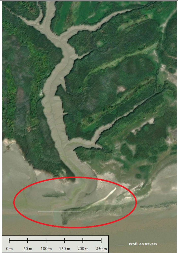
Localisation de la digue au niveau du débouché de la vasière artificielle
