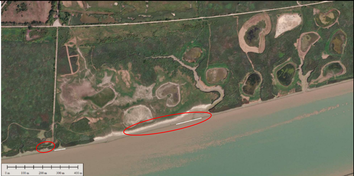
Localisation de la digue au niveau du débouché de la filandre estacade du Hode et de la crique du Hode
